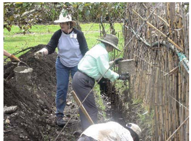
Carol Baughn and Betty Reichel pour the cement.
